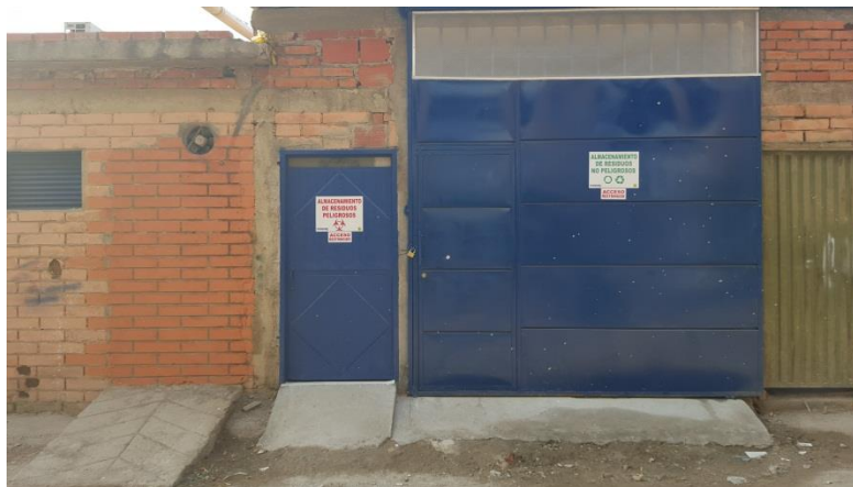
Foto 6. Exterior de los cuartos de almacenamiento de residuos peligrosos y no peligrosos.
