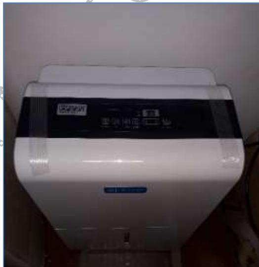
Para el control de la humedad, en depósitos de archivo se utiliza el deshumidificador, este aparato reduce la humedad ambiental filtrando el aire de una habitación y depositando el agua resultante de la condensación en un depósito para ello.
